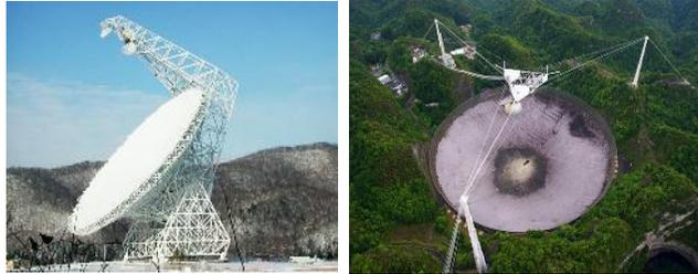
**El radiotelescopio es un instrumento que sirve para recibir las ondas de radio que provienen del espacio. Se utiliza una gran antena parabólica conectada a un aparato de amplificación y registro**
